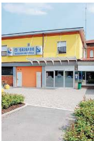
Ospedale. La struttura valsabbina
